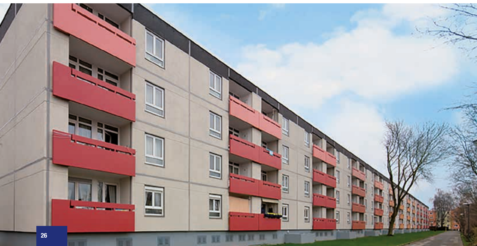
Lasierend beschichtet mit Beton Finish transparent im Farbton C3.27.44
