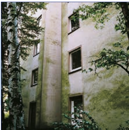
Die mit Moosen und Flechten befallene Fassade zunächst mechanisch säubern. Bitte die kommunalen Auflagen beachten und Mund- sowie Augenschutz tragen.
