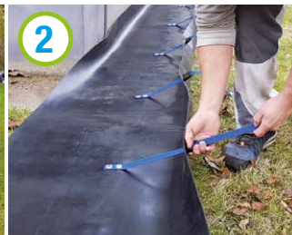
Fixierung der Spanngurte
