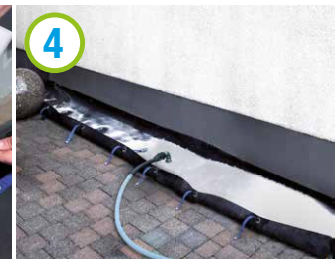
Abpumpen des Schmutzwassers
